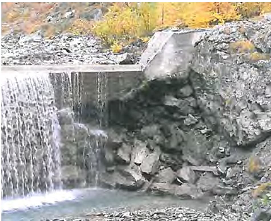
(b) Dettaglio dell'ammaloramento del paramento di valle, in orografica destra
