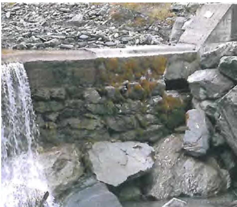
(b) Stato di degrado in orografia destra
