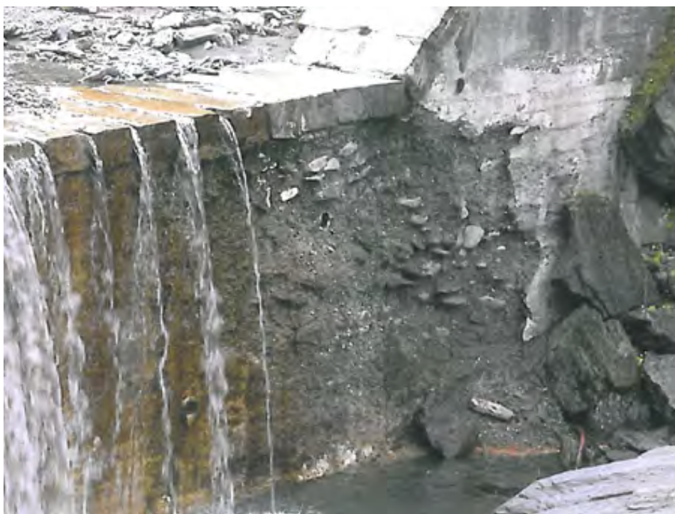
(b) Dettaglio dell'ammaloramento
