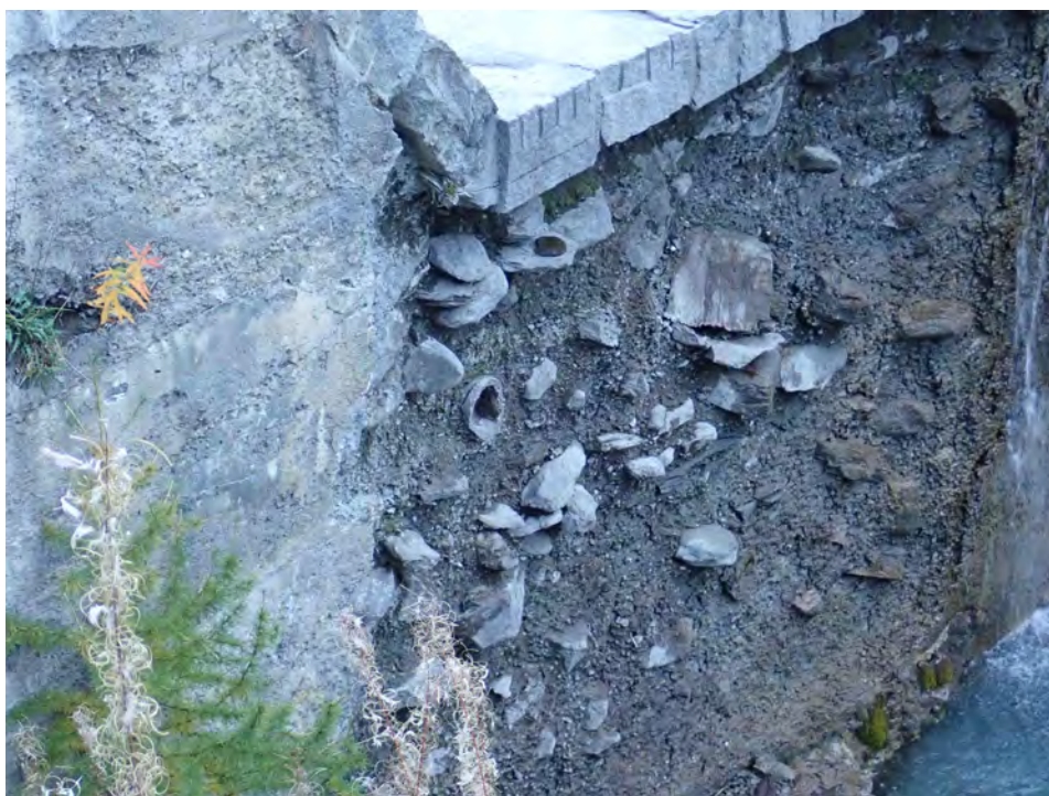
(b) Dettaglio dell'ammaloramento del paramento di valle
