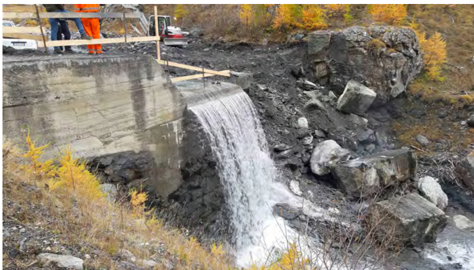
(a) Crollo durante i lavori di consolidamento
