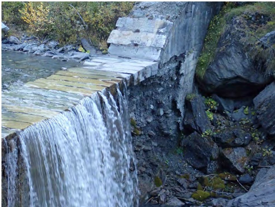
(a) Dettaglio dell'ammaloramento del paramento di valle
