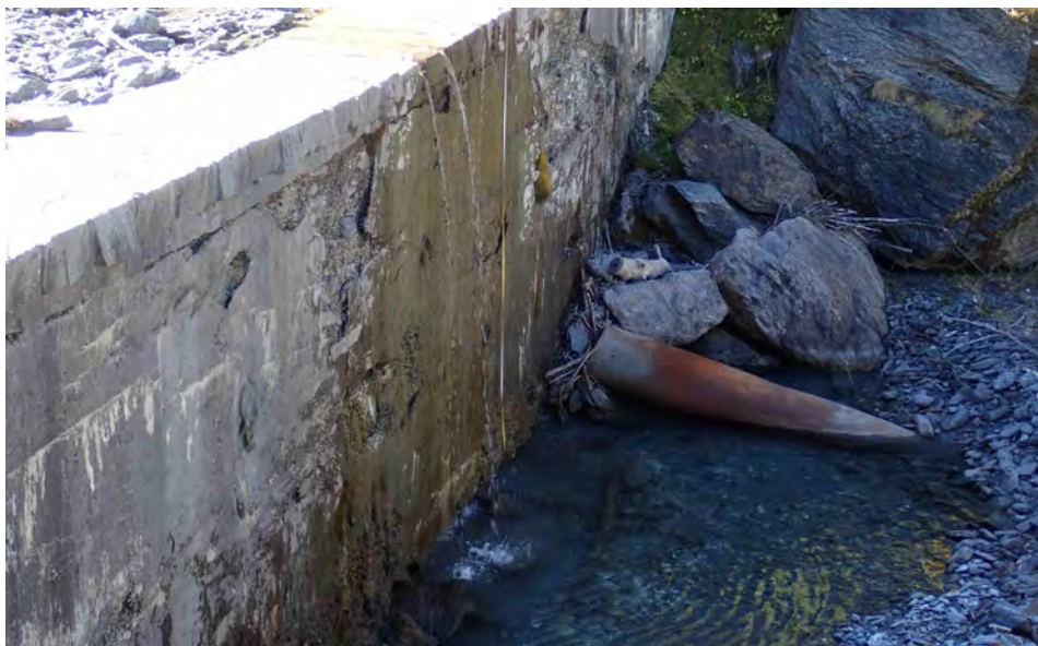
(b) Degrado del paramento di valle
